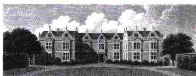
Parte aggiunta da Brown. Fronte meridionale originale. Parte aggiunta da Brown.
