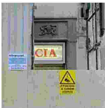
L'insegna della farmacia di piazza San Felice nascosta dal cantiere
