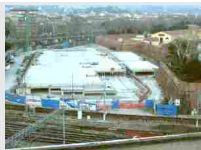
Fortezza, i lavori per realizzare il parcheggio interrato
