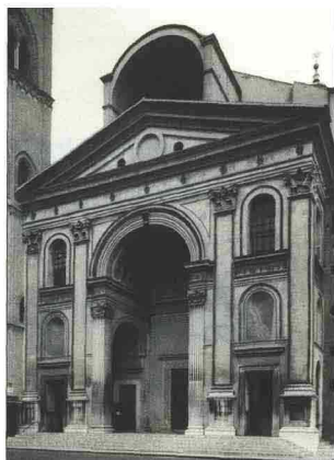
Facciata della chiesa di Sant'Andrea a Mantova (1470)
